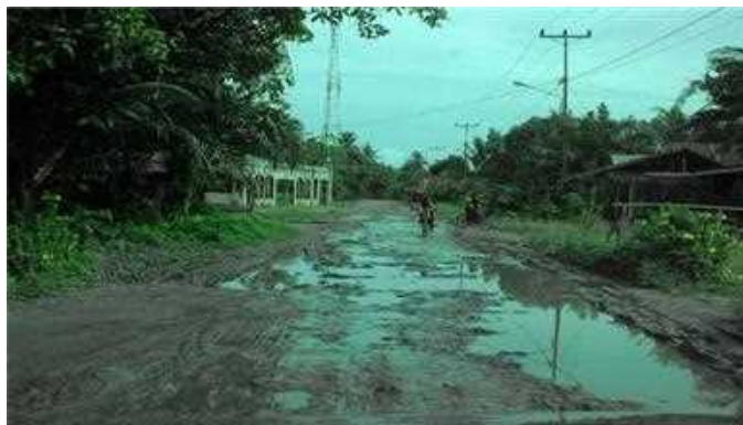
Gambar 5. Kondisi Infrastruktur Jalan
